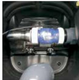
Rückschlagventil RSK und Entleerungspumpe
